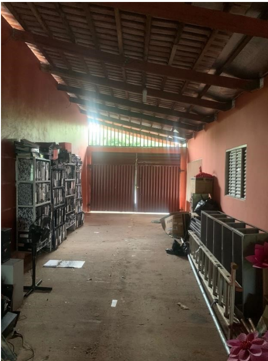
Imagem 63: Vista interna garagem
