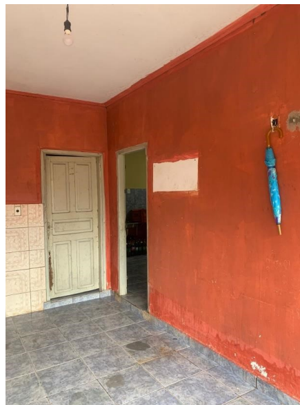
Imagem 37: Vista interna área de serviço
