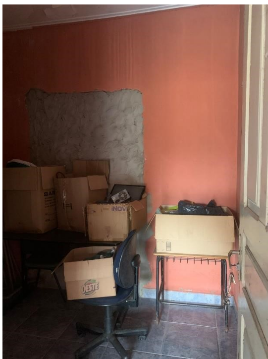
Imagem43 : Vista interna dispensa
