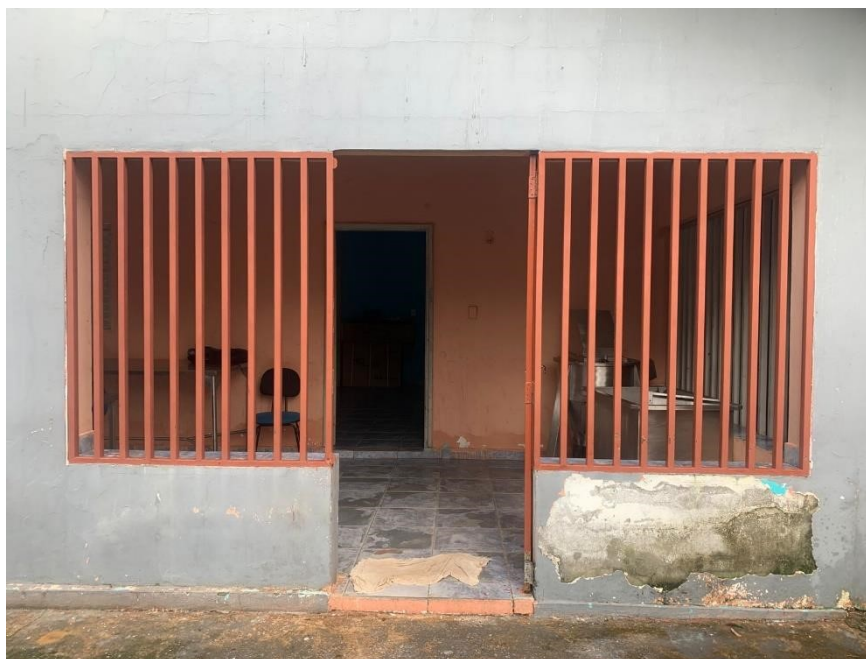
Imagem 3: Vista frontal da fachada
