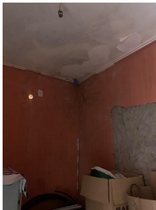
Imagem 44: Vista interna dispensa
