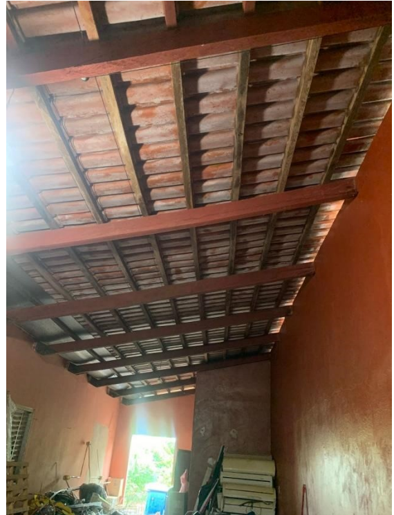
Imagem 62: Vista interna garagem
