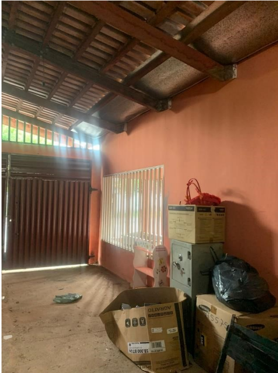
Imagem 61: Vista interna garagem
