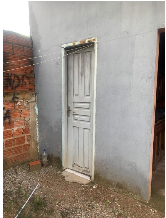
Imagem 64: Vista interna do terreno, frente com o banheiro 02
