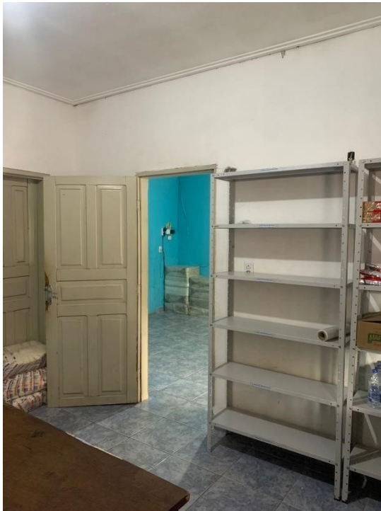
Imagem 19: Vista interna quarto 01
