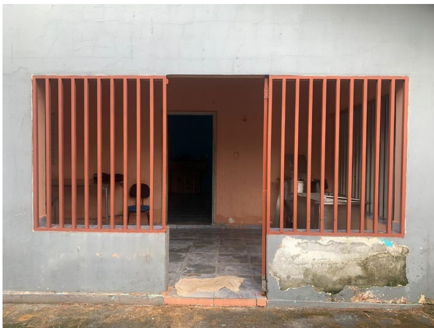
Imagem 3: Vista frontal da fachada
