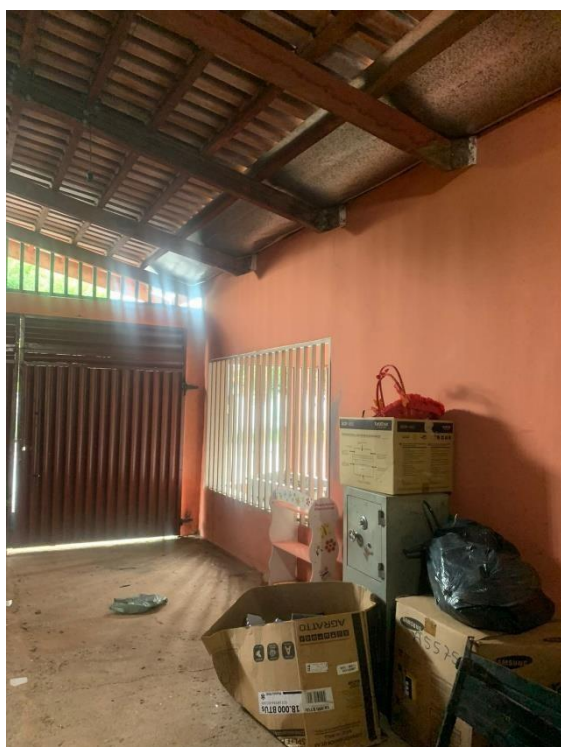
Imagem 61: Vista interna garagem
