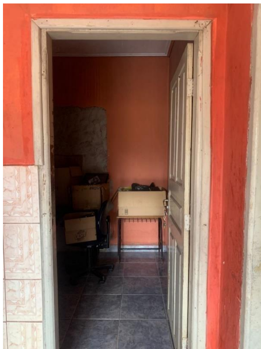
Imagem 42: Vista interna área de serviço, frente com a dispensa
