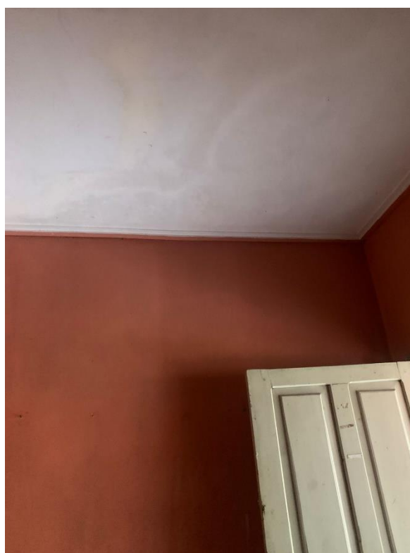
Imagem 46 : Vista interna dispensa
