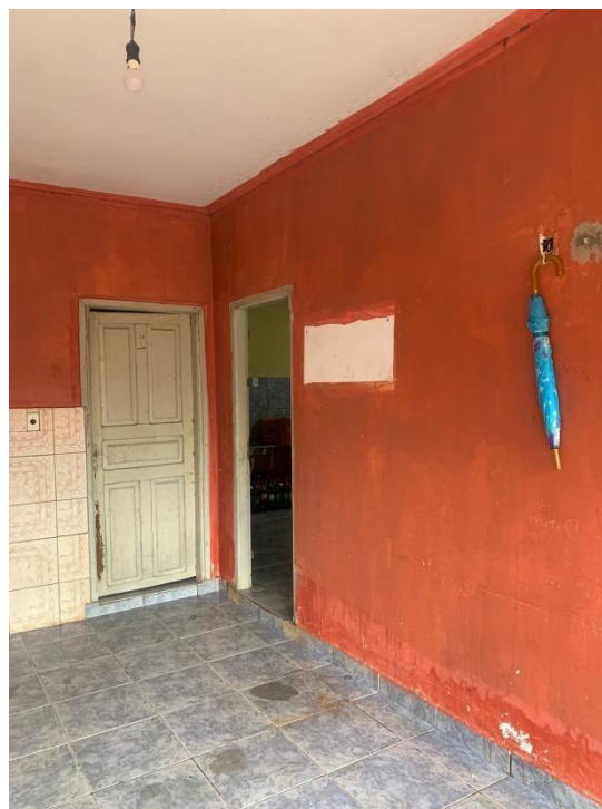
Imagem 37: Vista interna área de serviço
