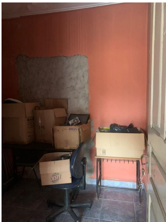
Imagem43 : Vista interna dispensa
