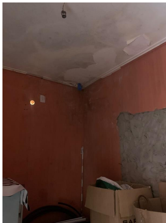
Imagem 44: Vista interna dispensa
