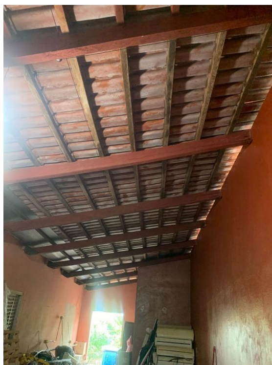
Imagem 62: Vista interna garagem
