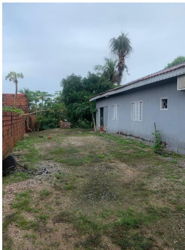
Imagem 50: Vista Interna do terreno, vista quintal urbano e muro lateral esquerdo
