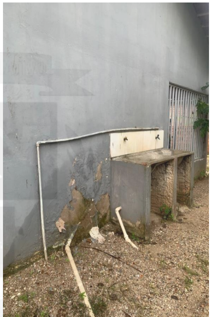
Imagem 52: Vista interna do terreno
