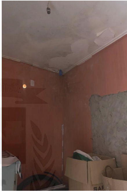
Imagem 44: Vista interna dispensa
