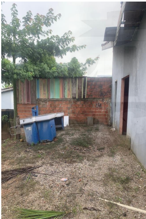
Imagem 53: Vista interna do terreno
