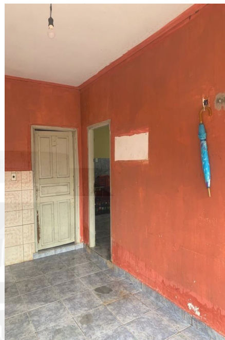
Imagem 37: Vista interna área de serviço
